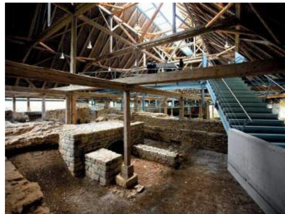
FIGURA 4.2: Hüfingen (Alemanha) Römische Badruinen. descoberta e protegida na década de 1890. A parede do perímetro repousa sobre fachadas romanas e a estrutura de madeira sobre estruturas arqueológicas.
