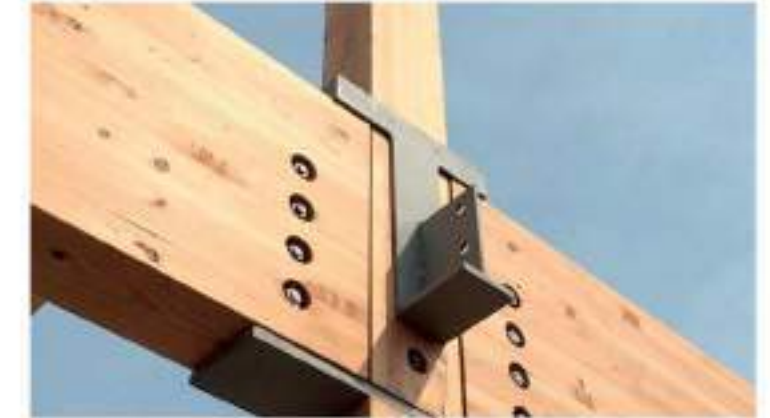
VIGAS PRINCIPAIS EM MADEIRA COM ALMA METÁLICA IMPLUVIUM ATRIO DOMUS
