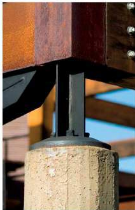
MICROESTACA DE BETÃO ARMADO
