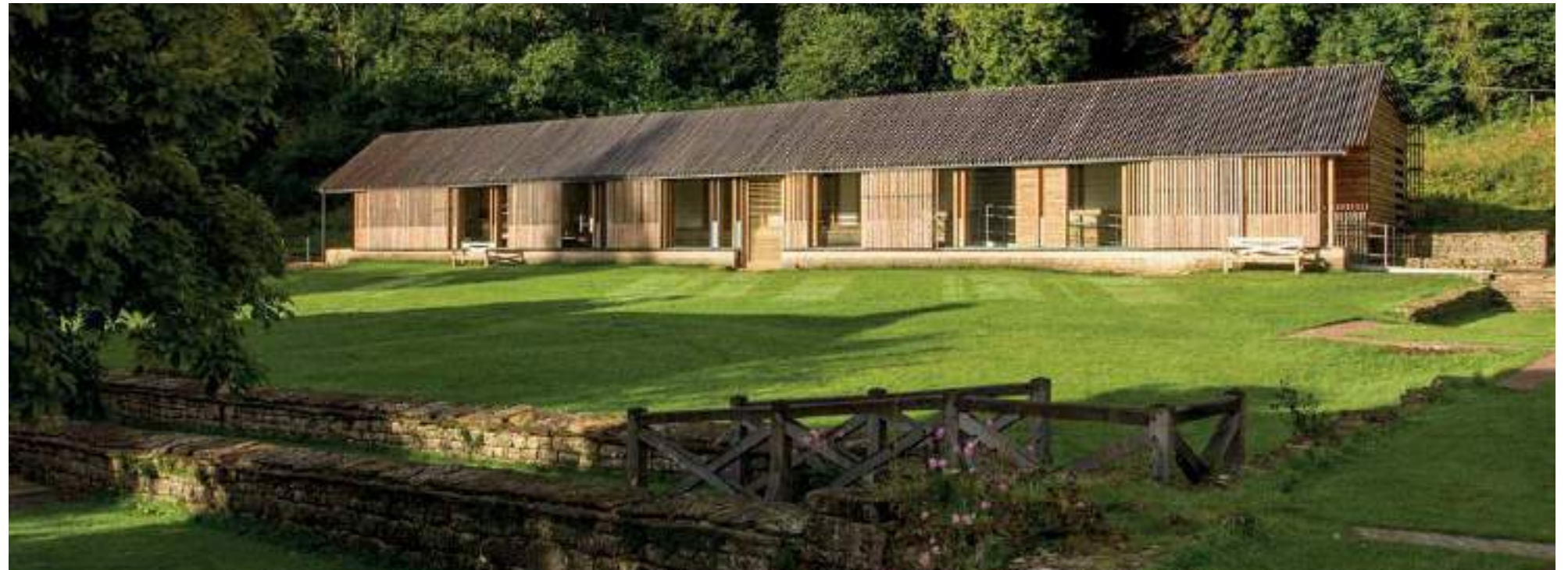
FIGURA 4.4: Villa de Chedwoth (Gloucestershire, Inglaterra). Na primeira intervenção (acima), um dos blocos da viila romana (paredes e teto) foi reconstruído com materiais tradicionais (madeira e alvenaria) para proteger os mosaicos. As novas intervenções na década de 90 do século XX foram realizadas em uma linguagem moderna (sempre com estrutura de madeira), embora continuassem aproveitando as paredes romanas.
